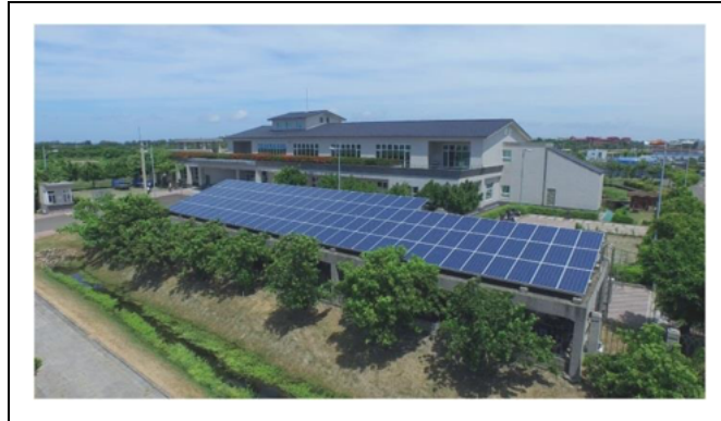
楠梓污水廠之屋頂太陽能板建置
