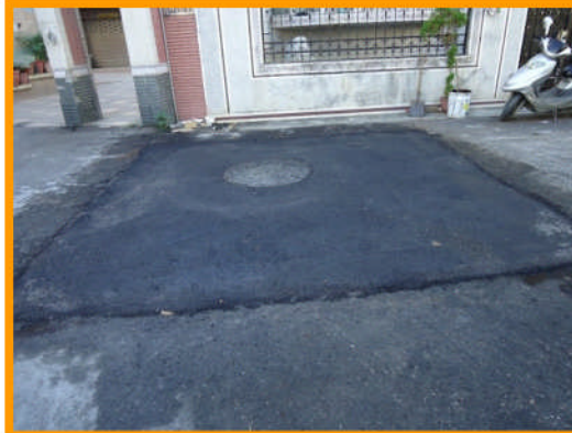
18.路面 AC 修復
