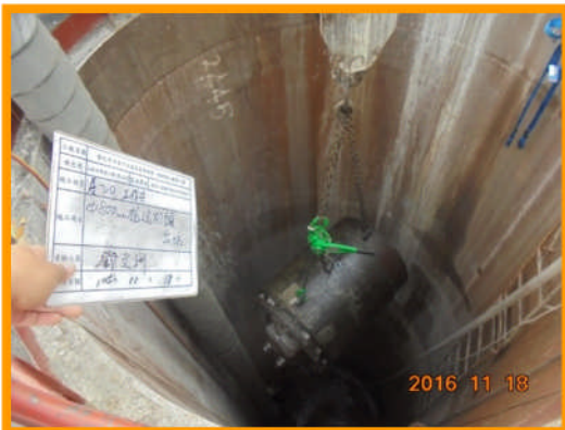
13.推進機頭出坑
