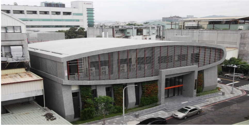
臺中加工出口區污水處理廠
