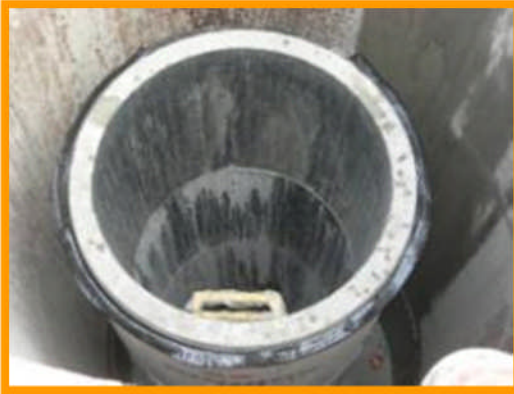
15.人孔短管吊裝組立及 安裝擠壓式填縫帶
