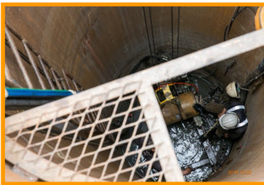
11.推進機頭入坑
