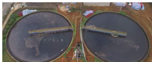
桃園市污水下水道系統水資源回收中心改善工程
