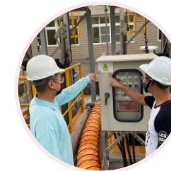
現場安全衛生查核
