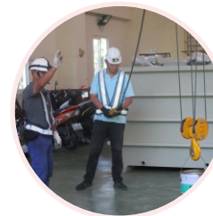
現場安全衛生查核
