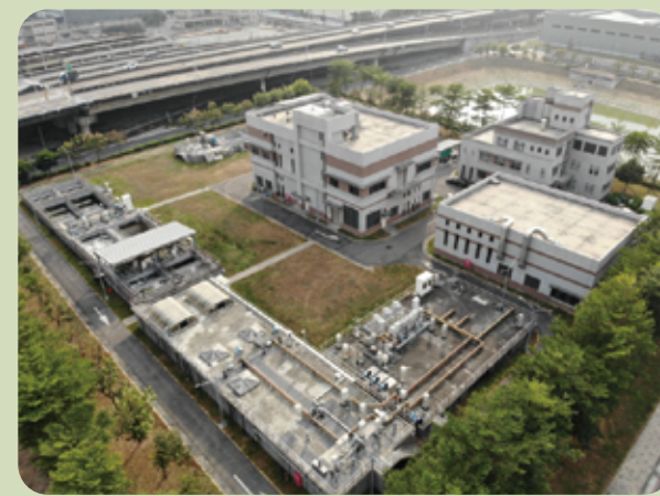
高雄市和發產業園區委託開發、出(標)售及 管理案-污水廠工程(污水處理廠工程二期)
