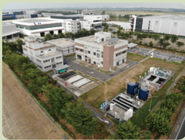
高雄市和發產業園區委託開發、出(標)售及 管理案-污水廠工程(污水處理廠工程)
